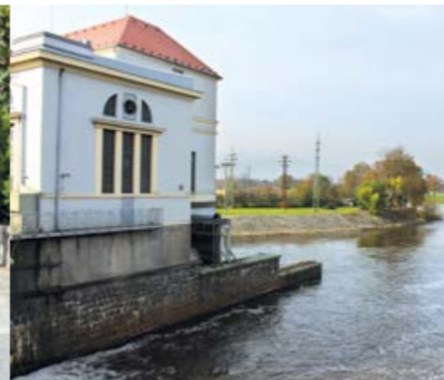
Přelouč small hydropower station
