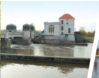
Přelouč small hydropower station
